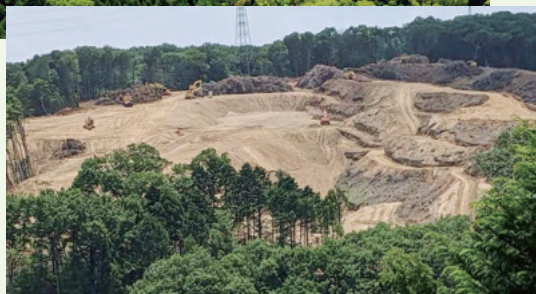
埼玉県飯能市の メガソーラー建設現場
